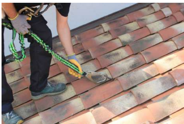
15. Collegamento all'ancoraggio
