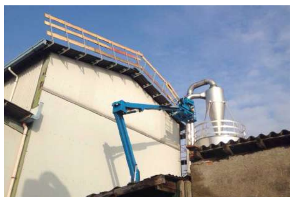
6. Montaggio parapetti con PLE
