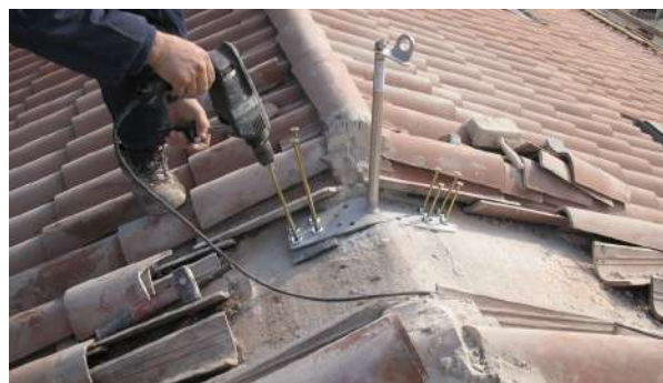
17. Installazione punto di ancoraggio
