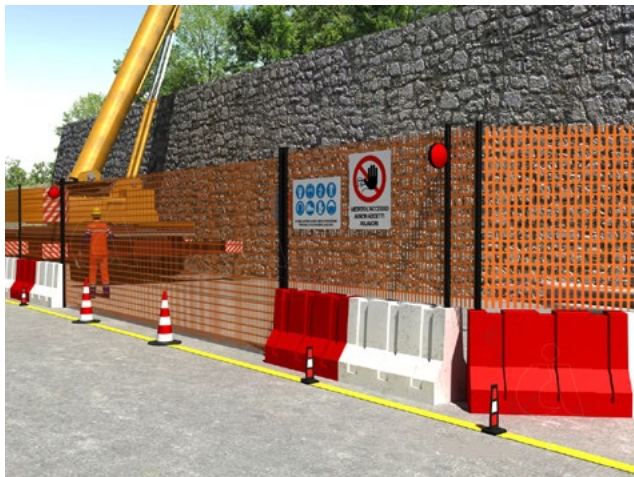
BARRIERE STRADALI "NEW JERSEY" (particolare di una delimitazione di cantiere)
